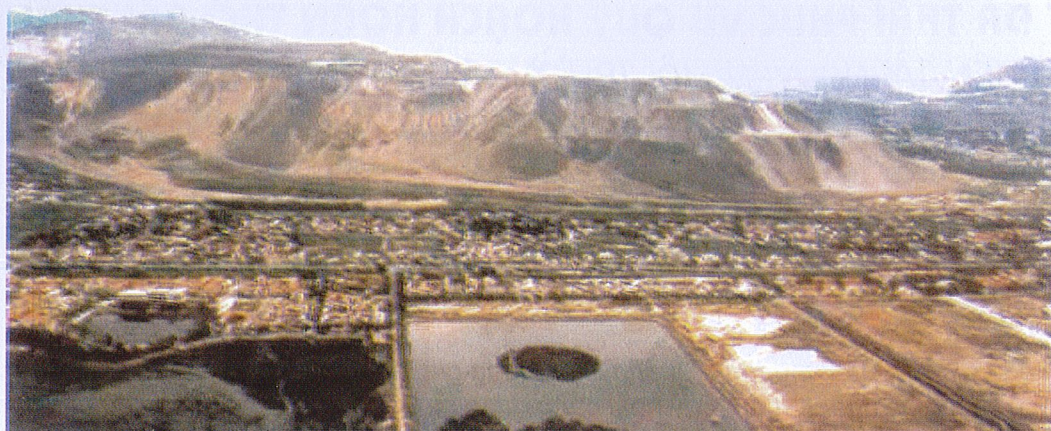
Hình 1: Toàn cảnh bãi thải Nam Đèo Nai và các khu vực dân cư lân cận
